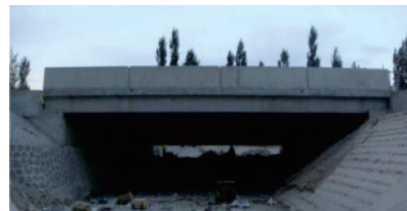
图14 试验桥梁实景
